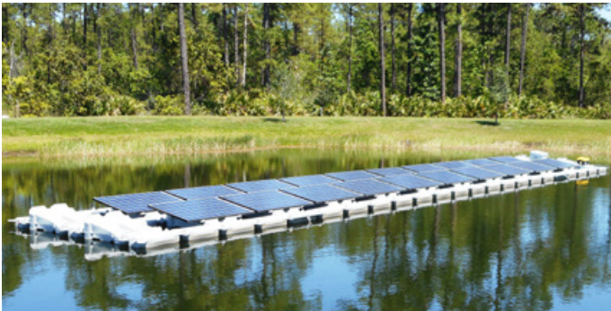
画像1: 20基のREC太陽光モジュールとCiel & Terre社のHydrelion®フロートを使用したセントラルフロリダ大学(米国オランダ)の5kWのフローティングPVシステム
