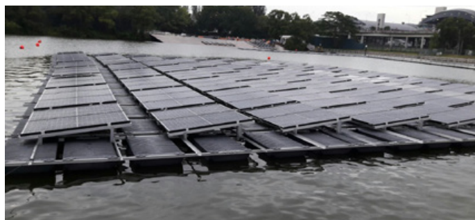
画像5: テンガ貯水池の試験水床でのRECフローティングセクションのフローティングフロート (O&Mのしやすさを考慮して、モジュール列間に通路を確保)
